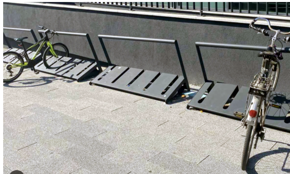
Slika br. 9 - Primer loše prakse parkinga za bicikle gde se bicikl za ram može vezati samo dužom sajlom, ali znatno teže i nepraktično U-lock bravom ili kraćim lancem ili sajlom
