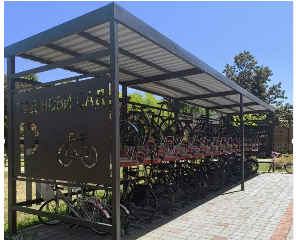
Slika br. 22 - Dvospratni pokriveni biciklistički parking između zgrade studentskih domova i Naučno-tehnološkog parka u Novom Sadu
